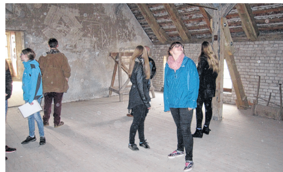
Der Häftlingsschlafsaal auf dem Dachboden der Lichtenburg.
