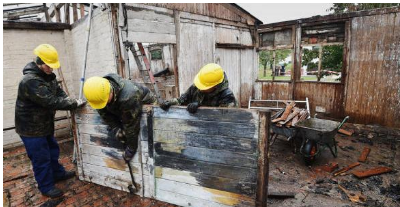
Bundeswehrosoldaten demontieren die historische Baracke.
