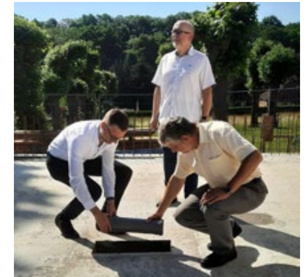
Grundsteinlegung und Versenkung der Zeitkapsel in der Bodenplatte des Neubaus der Gedenkstätte Großschweidnitz, 2021
