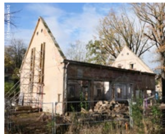
Überreste der ehemaligen Busgarage, 2024
