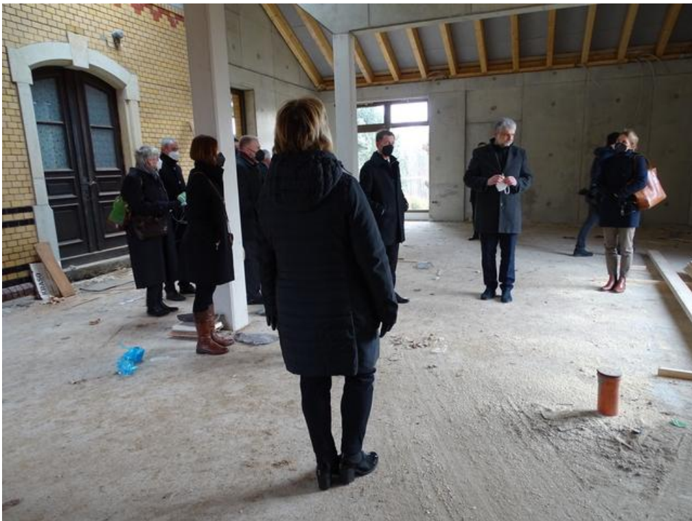
Rundgang über die Baustelle des Gedenkstättenneubaus (Foto: Stiftung Sächsische Gedenkstätten)
